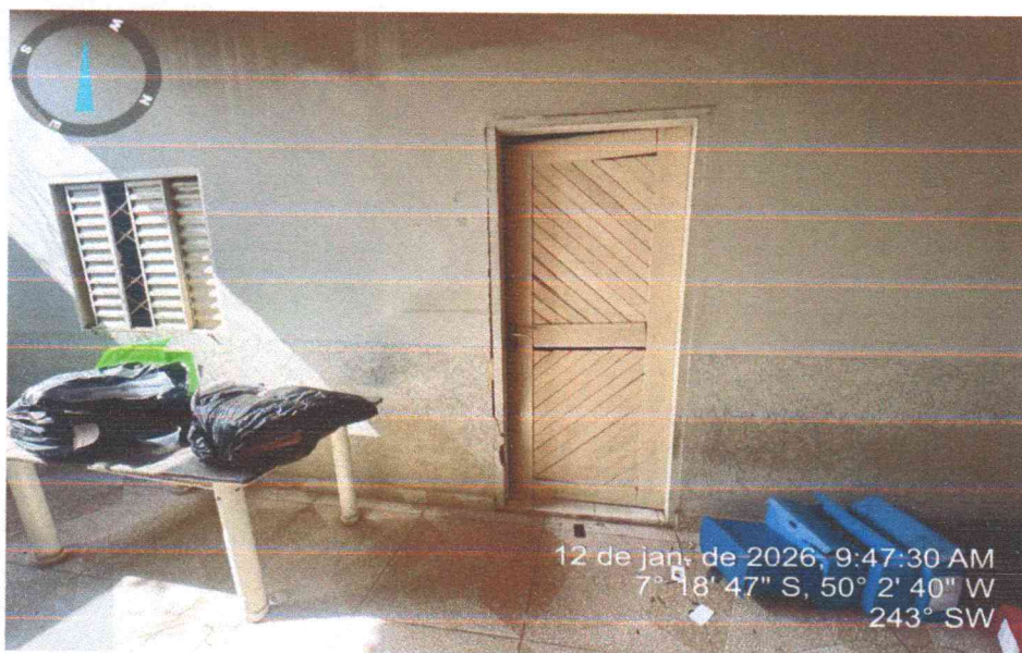
Foto 18 - Acesso para Sala 01 e 2
