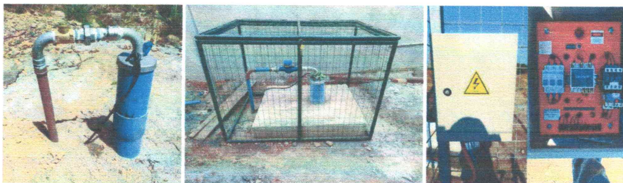
Figura 1: Imagens ilustrativas dos produtos (poço ligado a rede, grade com laje sanitária, painel de acionamento de bomba).
