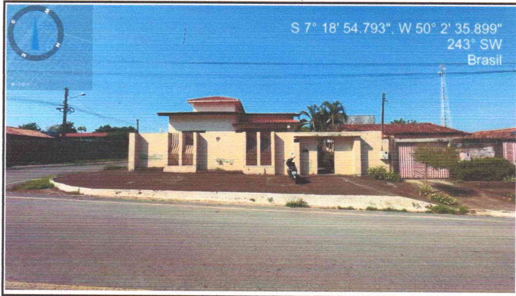
Foto 01- Fachada Frontal, frente para Avenida 08
