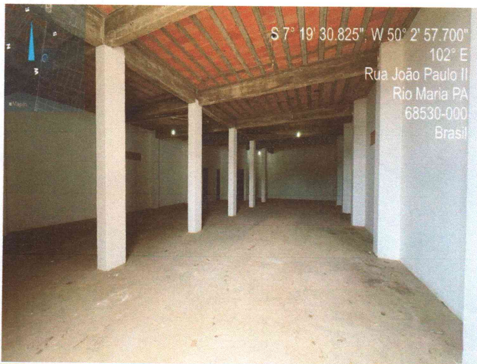
Foto 02 - Galpão Pav. Térreo
